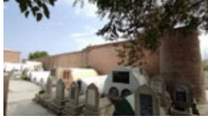
Fotoğraf 2: Kuzey Cephe Görünümü.
