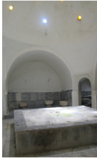
Resim 2: Afyon Sultandağı Yeşilçiftlik Belediye Hamamı- Sıcaklık bölümünden kurna başı, kare şeklinde göbek taşı ve 4 adet halvet hücrelerinden birinin girişi ve kubbe görünüşü. (Banu Apaydın Başa fotoğraf arşivi, 2009)
